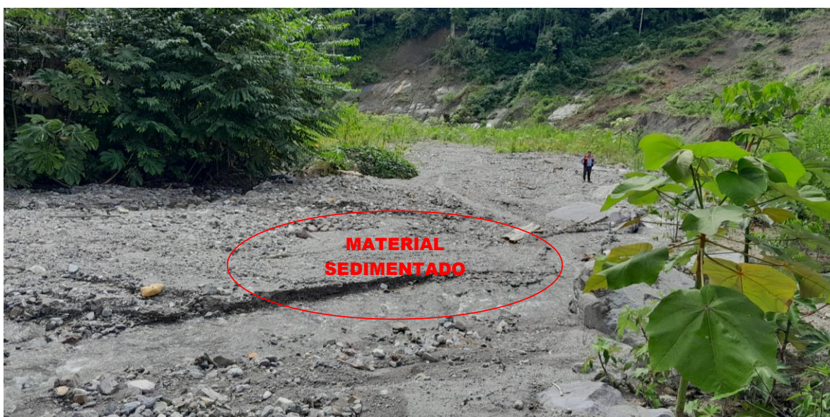
FIGURA N°02: MATERIAL COLMATADO EN EL CAUCE DEL RÍO KORIBENI, CON UNA PROFUNDIDAD PROMEDIO DE 1. 50M. ESTO PROVOCA QUE DESBORDAMIENTO DEL RÍO SEA MAS INMINENTE.
